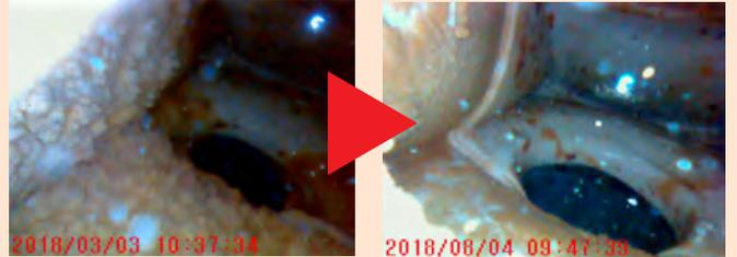
写真は小便器のトラップ内部をCCDカメラで撮影したものです。排水口付近を覆っていた尿石はナノゲート設置5ヵ月で大きく剥離し、詰まりを防止している様子が確認できます。
