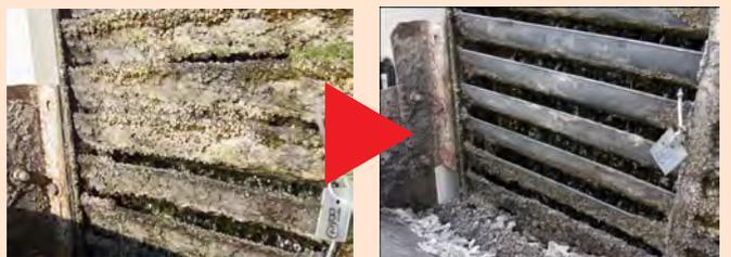
写真は冷却塔への効果事例です。ルーバを塞いでいた大量のスケールは6ヵ月間で自然剥離、冷却効率を大きく改善しています。
